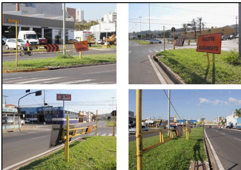
Figura 11 – Local de instalação da cancela, na Avenida Nações Unidas X Rua Aparecida.
